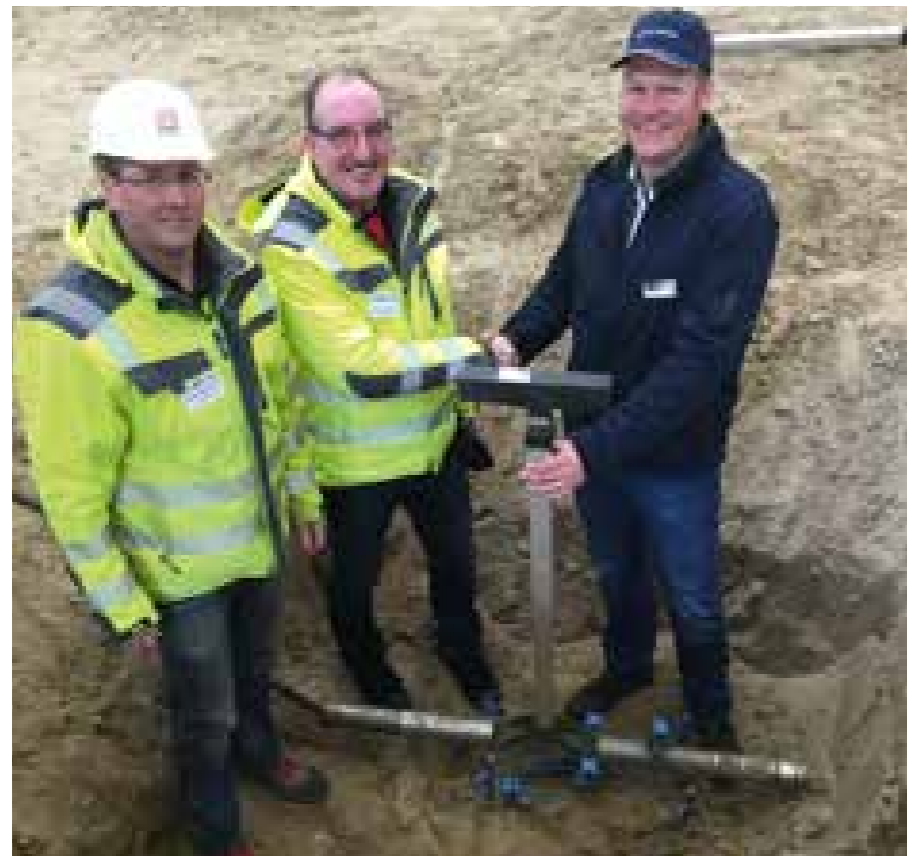
V.r.n.l.: Stefan Kruse übergibt die GRUNDOMAT 130PK und 75P samt Zubehör an Hermann Greve, Leiter Maschinen- und Metalltechnik, und Stefan Wiedenstried, Lehrmeister Straßenbau / Rohrleitungsbau vom Bau-ABC-Rostrup auf den Bohrtechnik-Tagen 2017.
