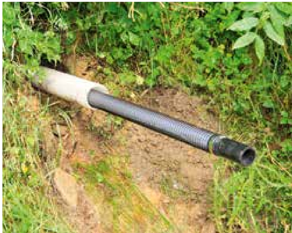
Im HDD-Verfahren eingebautes Drainagerohr im Berghang. Der Aquaplus-Filter wird von Hand eingeschoben.
