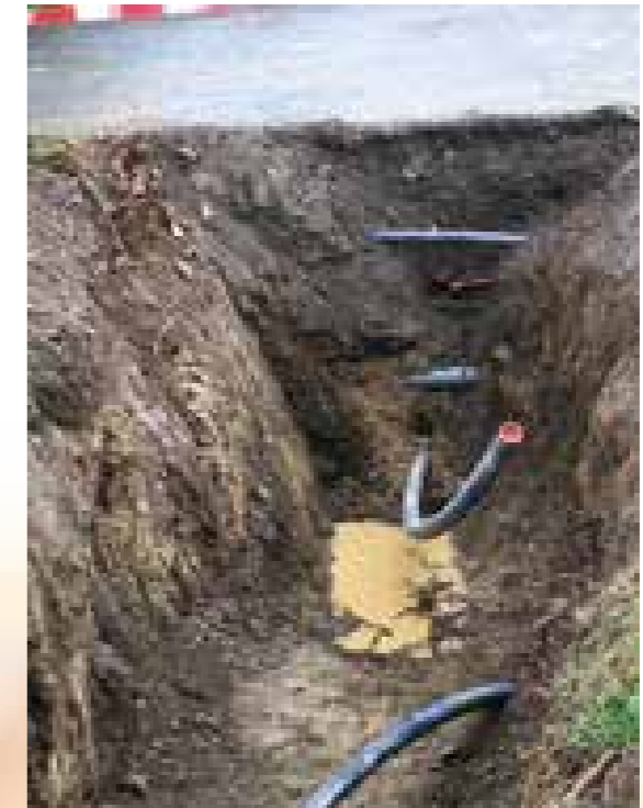
Das verlegte Rohr.
