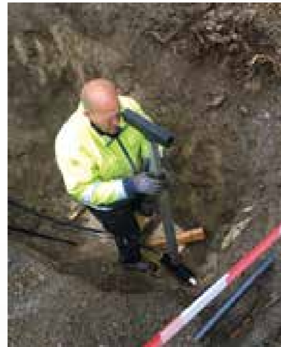
Die Verlegung erfordert höchste Präzision.
