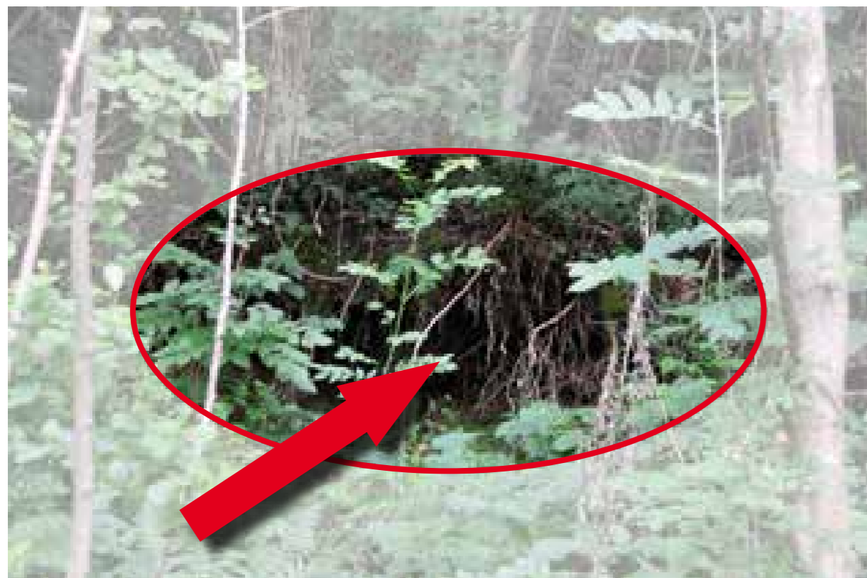
Das Schadensbild: Freigespültes Wurzelwerk.
