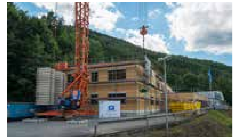
Gesamtansicht des zukünftigen Technologiezentrums oberhalb der Karlshütte mit dem neuen Bürogebäude im Vordergrund und dem zur Entwicklungswerkstatt umgebauten bestehenden Gebäude im Hintergrund.
