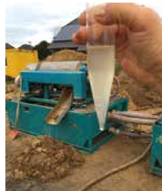
Bild links und Mitte: Der neue Trailer SRU2017. Im Einsatz für die Firma REVOR bei der Erstellung einer komplizierten 400 m langen Felsbohrung in Lohmar.
