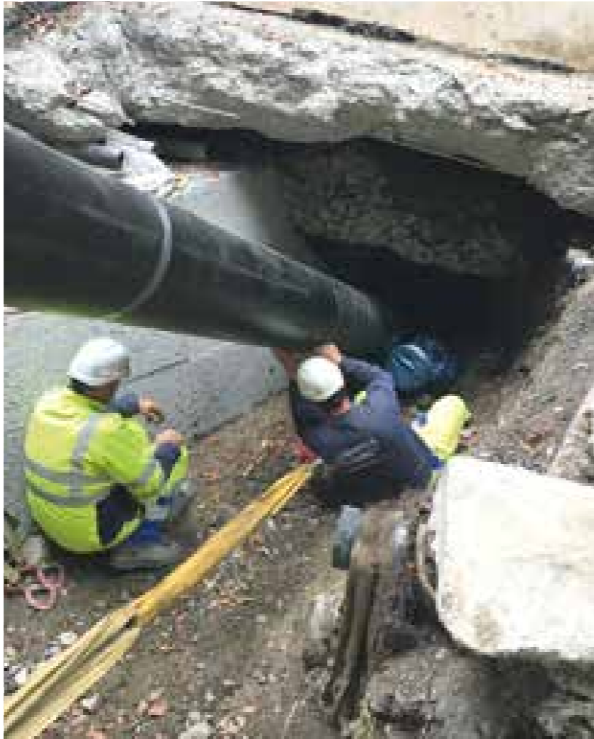
Das neue PE-ummantelte Duktill-Gussrohr DN 300 bei der Verlegung.
