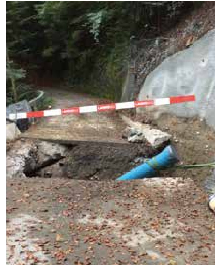
Das kleinere, PE-ummantelte Duktill-Gussrohr DN 250 nach der Verlegung.
