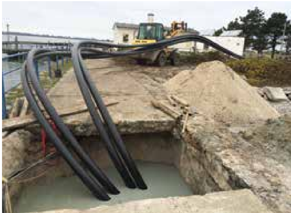
Die Zielbaugrube in der Mole während des Rohreinzugs.
