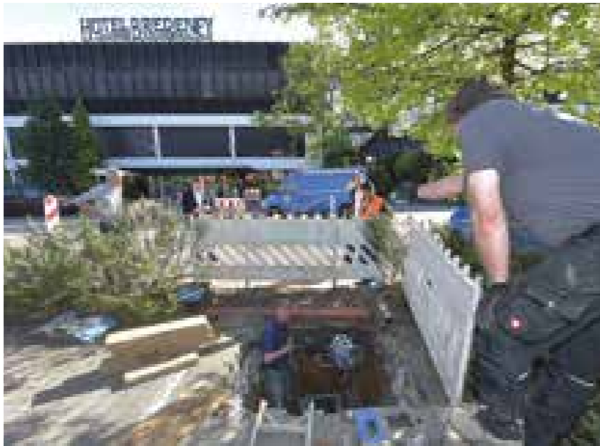
Blick vom Startpunkt der Bohrung auf dem Parkplatz des Hotel Bredeneu zum Standort der Ladesäule.
