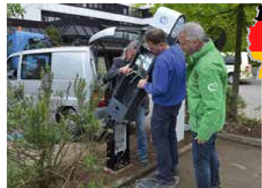
Bild Mitte und rechts: Nachdem das Kabel unterirdisch verlegt wurde, wird oberirdisch die Ladesäule an das Stromnetz angeschlossen.
