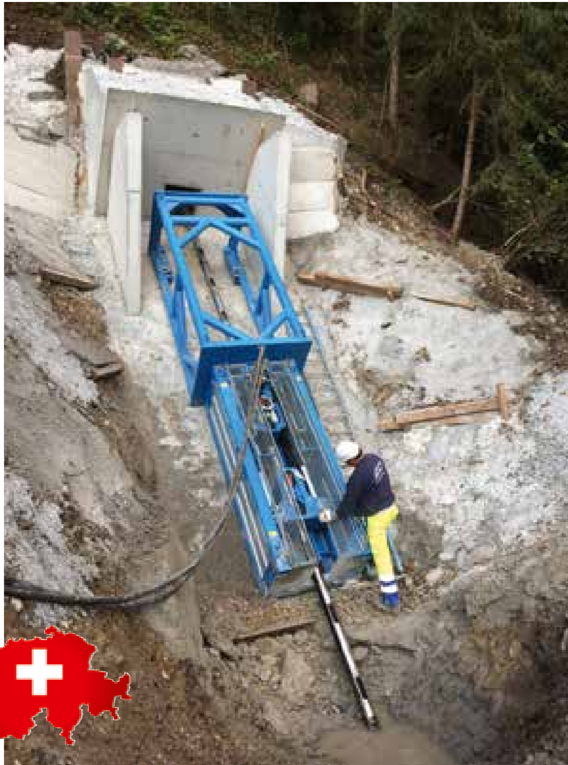
Der in der Baugrube installierte GRUNDOBURST 1900G mit Vorsatzrahmen.
