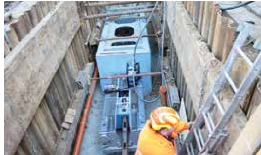
Bild links: Der Berstkopf. • Bild Mitte: Der in der Baugrube installierte GRUNDOBURST 2500G mit Vorsatzrahmen. • Bild rechts: Das Quick-Lock-Gestänge.
