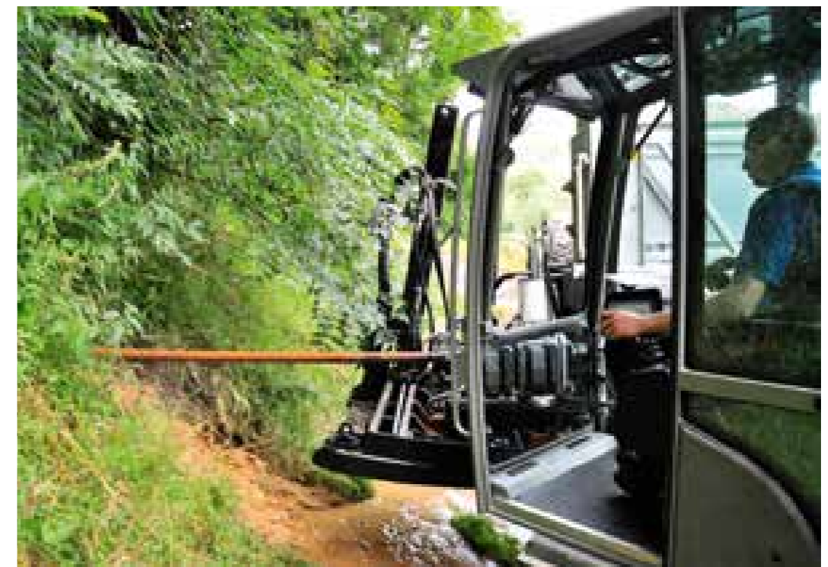
HDD-Bohrung in den kriechenden Berghang.
