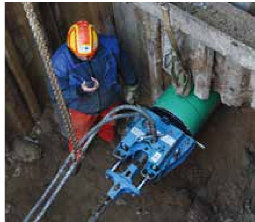
Bild links: Die neuen PP-Rohre DN 450 vor der Verlegung. • Bild Mitte: Über Funk stehen die Mitarbeiter in der Maschinengrube während des Einzugs der PP-Kurzrohre in ständigem Kontakt mit den Kollegen in der Einziehgrube. Bild rechts: Das Neurohr mit dem Aufweitkopf hat die Maschinengrube erreicht.
