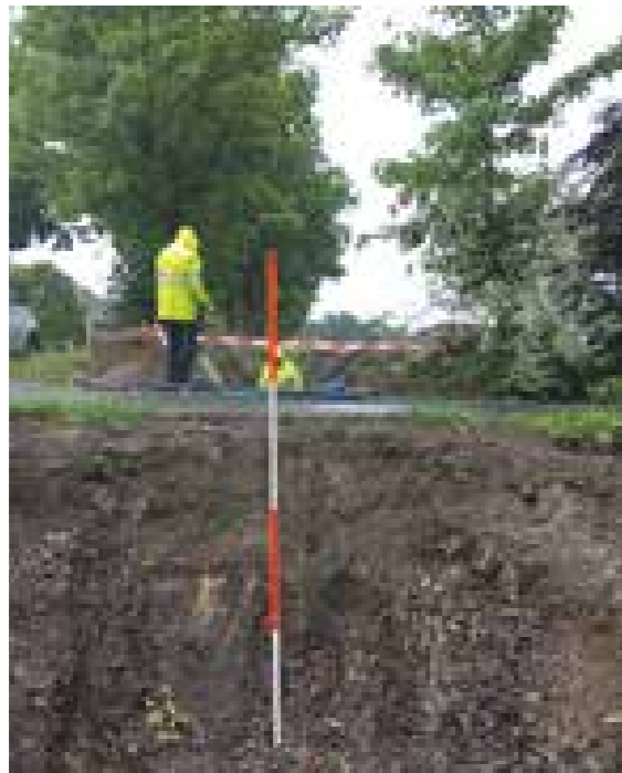
Blick von der Ziel- in die Startgrube.
