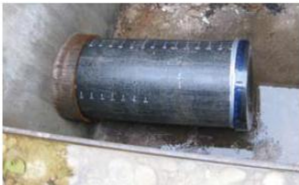
PE-natěsno v trubce – po uvolnění v cílové jámě.
