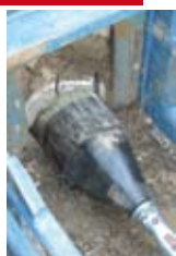
Nová trubka těsně přiléhá ke stěně staré trubky.
