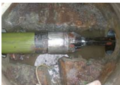
Zatažení trubního vedení BURSTFORMem skrz šachtu
