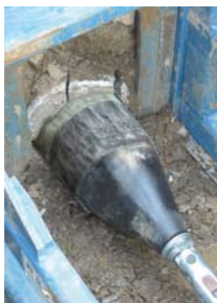
Trubka vtažená do cílové jámy.
