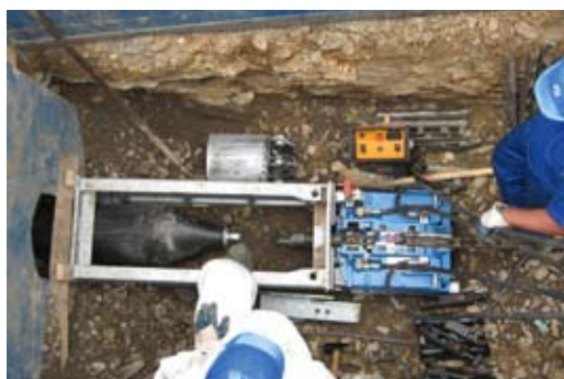
V těsných místních podmínkách je GRUNDOBURST 400S také nasaditelný z (malých) stavebních jam.
