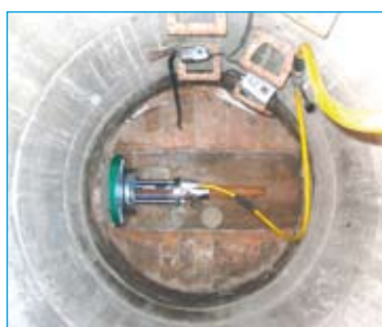
BURSTFIX–typ 200 v šachtě.
