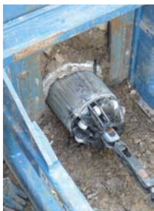
Vodící hlava s vodicími rolnami vyrovnává deformace.
