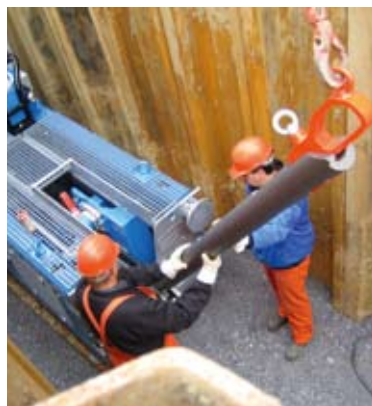
Instalace trhací tyče speciálním zvedacím zařízením
