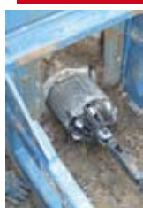
Vodící hlava vyrovnává deformace.
