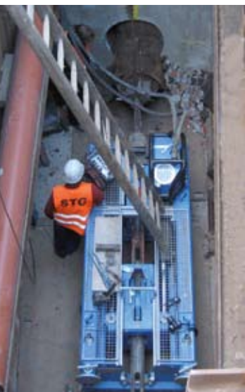
Instalace trhací tyče speciálním zvedacím zařízením
