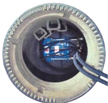
Pohled do šachty s GRUNDOBURSTem 400S (nadhled sicht)
