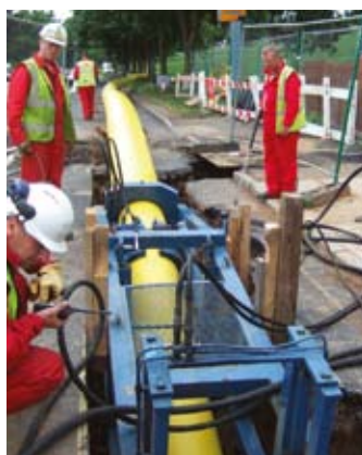
Nová trubka těsně přiléhá ke stěně staré trubky.
