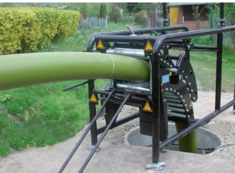
Zatažení trubního vedení BURSTFORMem skrz šachtu
