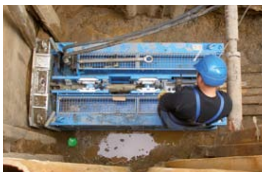
Teleskopické opěry pro zadní a boční podepření pro typy 1250, 1900 und 2500G
